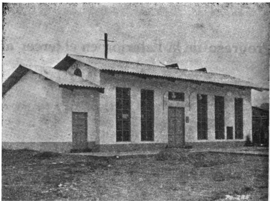
Edificio de la "CENTRAL ELECTRICA" destinada a cubrir las necesidades en energía eléctrica tanto de la Estación como de la Población de Tingo María
