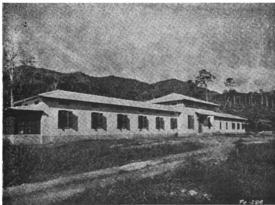
Edificio de Laboratorios para trabajos científicos con plantas tropicales
