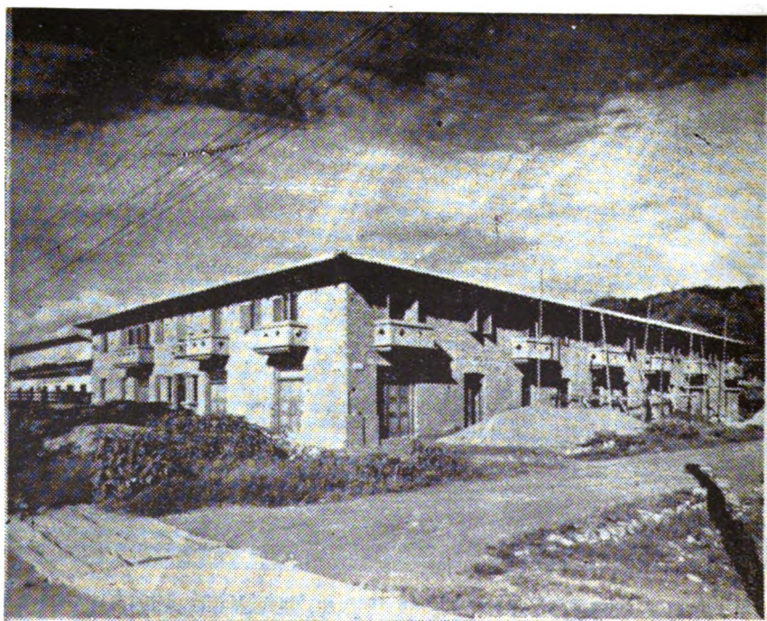
Moderno hotel en plena construcción y que en 1946 muestra evidentemente el progreso del Pueblo de Tingo María
